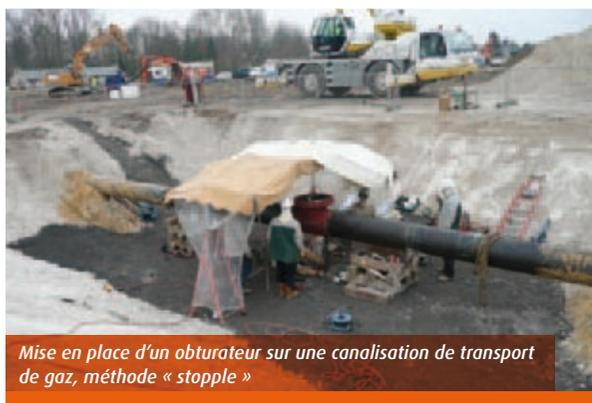
Mise en place d'un obturateur sur une canalisation de transport de gaz, méthode « stopple »
